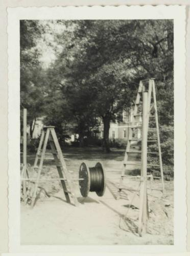
UNDERGROUND WIRING BEING PLACED FOR NEW COURTHOUSE LIGHTING SYSTEM
